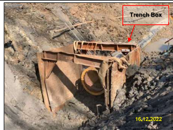
รูปที่ 2-10 การติดตั้ง Sheet Pile หรือ Trench Box เพื่อป้องกันการพังทลายของดิน
