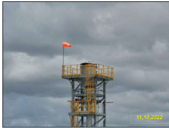
ติดตั้งอุปกรณ์ควบคุมเสียง (Silencer) ที่ปล่องระบายก๊าซ (Vent Stack)
