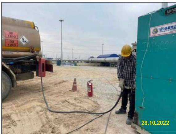
รูปที่ 2-16 รถบริการน้ำมันเชื้อเพลิงเพื่อใช้ในกิจกรรมต่างๆ ในพื้นที่ก่อสร้าง
