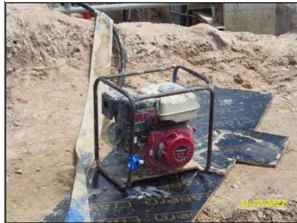
รูปที่ 2-22 เตรียมเครื่องสูบน้ำแรงดันต่ำ สำรองไว้ใช้งานตลอดระยะเวลาการก่อสร้าง
