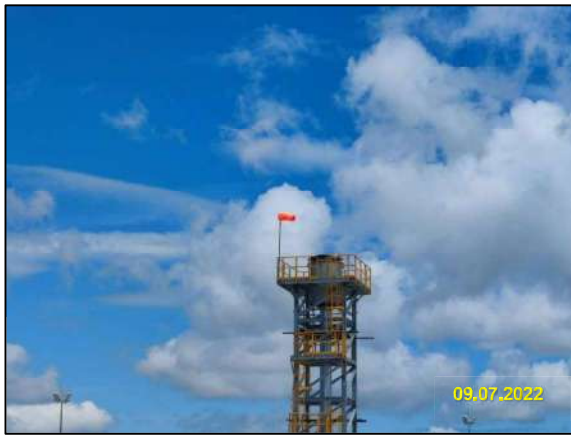
ติดตั้งอุปกรณ์ควบคุมเสียง (Silencer) ที่ปล่องระบายก๊าซ (Vent Stack)
