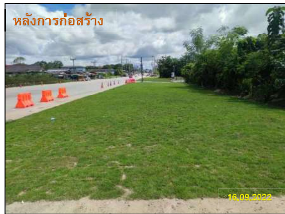
รูปที่ 2-37 (ต่อ) การคืนสภาพพื้นที่หลังการก่อสร้างแล้วเสร็จ (Reinstatement)
