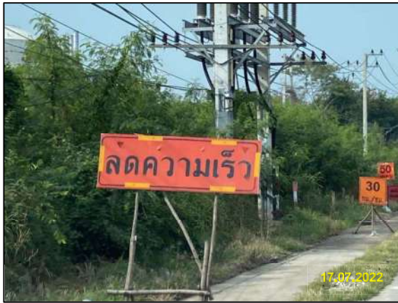
รูปที่ 2-20 การติดตั้งป้ายลดความเร็วและจำกัดความเร็ว
