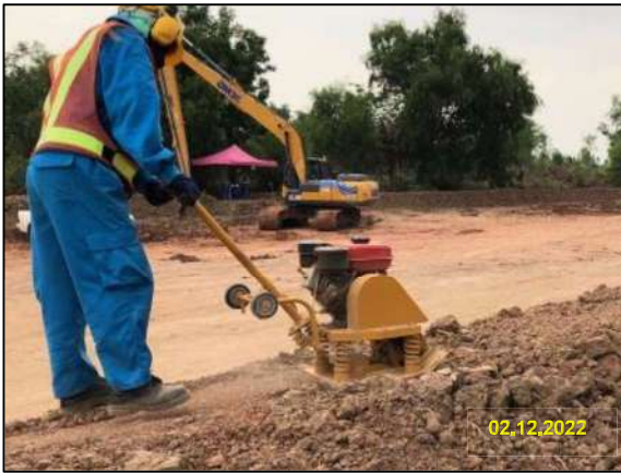
ซ) การבודัดพื้นป้อและผนังบ่อทิ้งโคลนโซเดียมเบนโทไนท์ (ช่วงเตรียมบ่อ)
